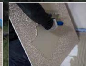
Zur Verlegung großformatiger Fliesen empfehlen wir, zwecks nahezu hohlraumfreier Verlegung, die Verarbeitung im kombinierten Verfahren.
